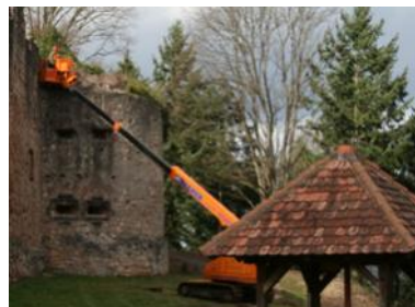
Der Hubsteiger im Einsatz !
