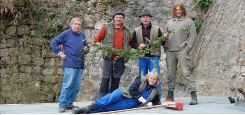
Ein Teil der Arbeitsgruppe auf dem renovierten Dach über der Pfisterei.
