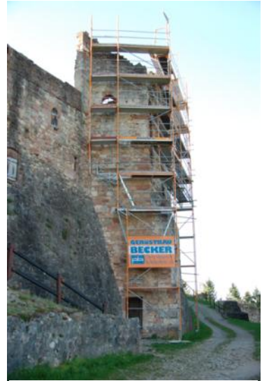
Der Kapellenvorbau, während der Sanierung
