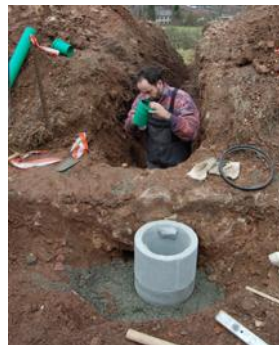
Verlegen der Entwässerung.
