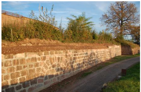
Das Neue Werk nach der Sanierung.
