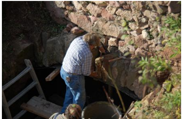
Bastion Hachberg, Sicherung des Randbogens
