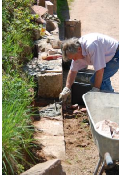
Versetzten der Quadersteine !
