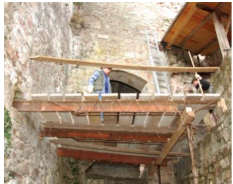
Roßmühle, eingebautes Podest.
