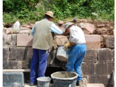
Versetzen von Quadersteinen.
